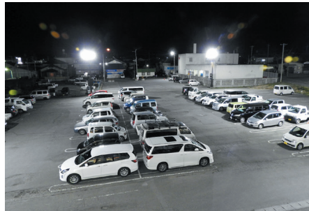
店舗の外照と駐車場の照明もLEDに。160～400Wの水銀灯から18～180WのLEDに変更した
