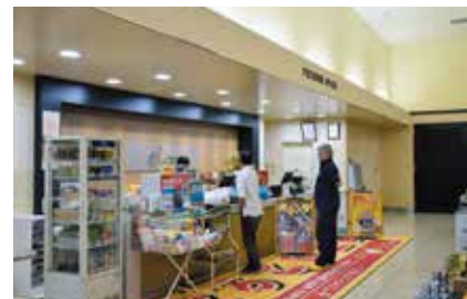
外壁のみならず、店内、駐車場など、すべての照明をアクシア製に。「5年間の補償付き（同社が交換・修繕）だから安心」と西原店長。導入して1カ月経ったところだが、11万4000kwだった電力使用量が、2万7000kwに減少した
