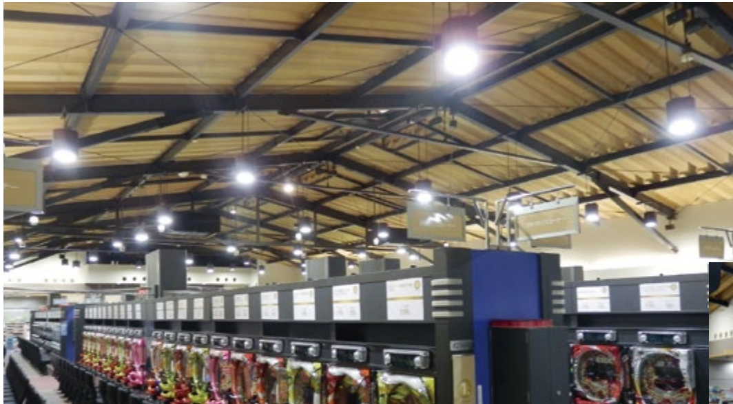
昨年4月にアクシアのLED照明を導入した福島県郡山市にあるニラク安積店（パチンコ320台、パチスロ160台）。LEDの欠点であるギラつきを抑え、光を拡散させる特殊カバーを付けたアクシア製の照明が、店内全体を明るく見せている
